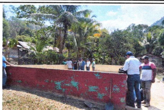
Foto 2: Vista de la base estructural de las dos aulas a remozar.
