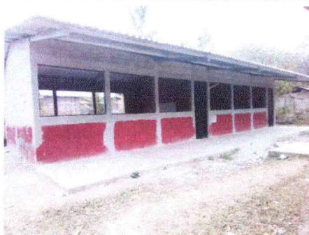
Foto 5: Colocación de la nueva estructura de entechado de las dos aulas.
