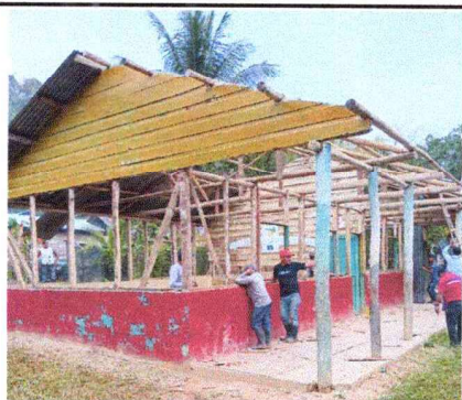
Foto1: Desmantelamiento de la estructura inservible de las aulas.
