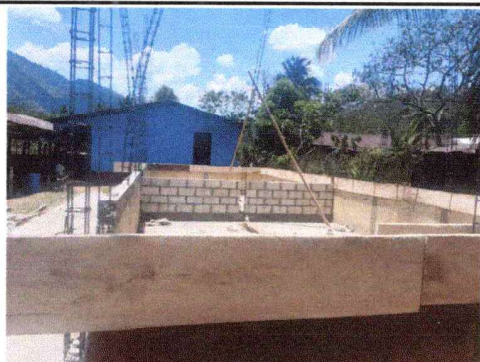
Foto 3: Colocación de nueva estructura de los dos salones de clases.
